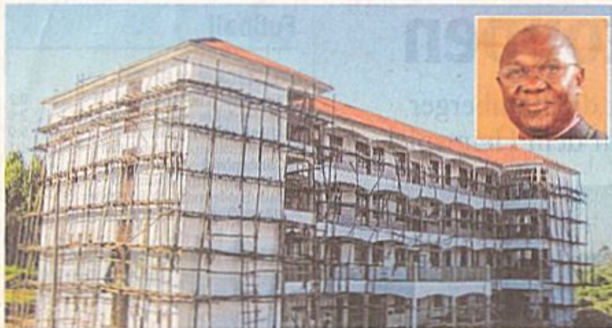
So sieht der vom Uganda-Hilfverein unterstützte Schulhausbau vor seiner Fertigstellung aus. Kleines Bild: Pater Larry.
